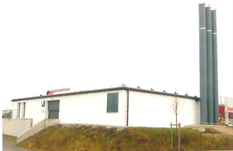
▲ Neubau der Energiezentrale in Germering, Ansicht Nord
