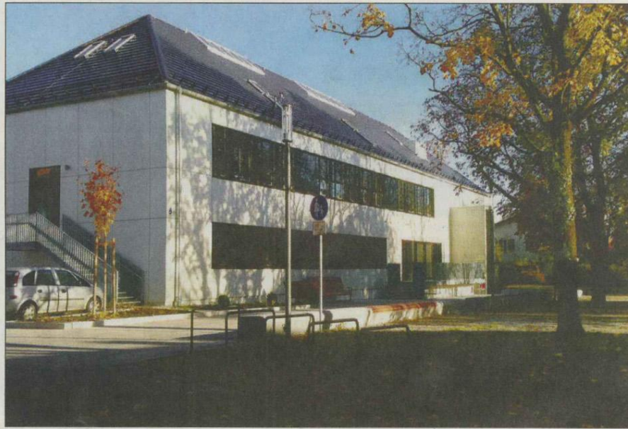
Die umgebaute alte Knabenschule.
