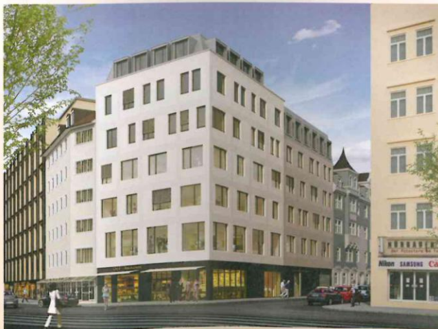
Bei diesem Projekt konnte durch die thermische Gebäudesimulation eine Lösung gefunden werden, um die benötigte Kühlleistung zu erreichen, ohne ein größeres Kühlaggregat einsetzen zu müssen, das aus Platz- und Genehmigungsgründen nicht möglich war. Bild: RendEffect
