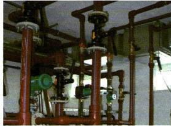
Vorgefertigte Rohrtypen erleichtern die Montage auf der Baustelle
