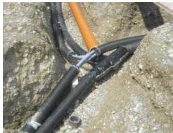
Flexible Kunststoff-Doppelrohre „von der Rolle“
