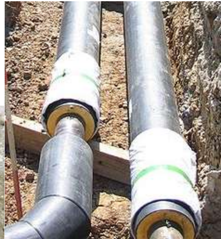
Starres Kunststoffmantelrohr (Mediumrohr aus Stahl)
